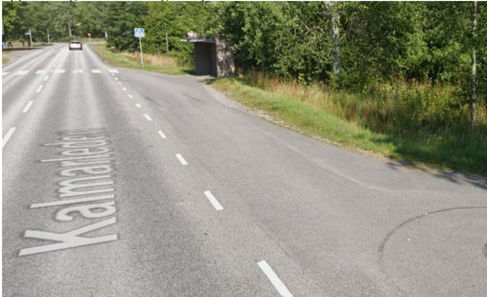
Figur 7. Exempel på bristfällig utformning av busshållplats (Hållplats Smultronstället). Hållplatsen saknar bland annat plattform och ligger för nära övergångsstället i bilden. Bildkälla www.enrio.se
